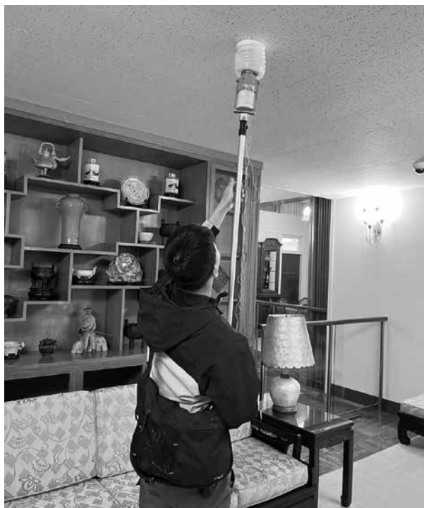
七海寓所內部消防安檢
